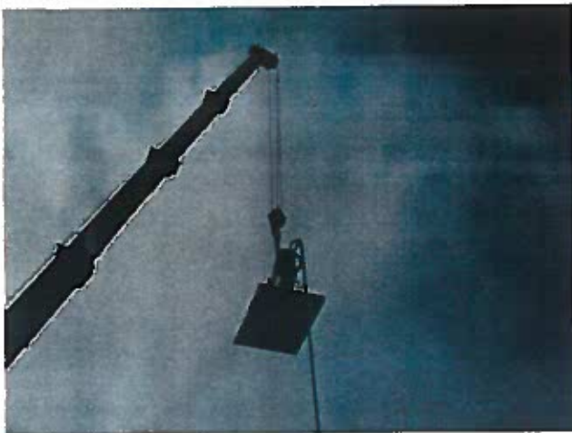
Vibrator ophængt i kran
