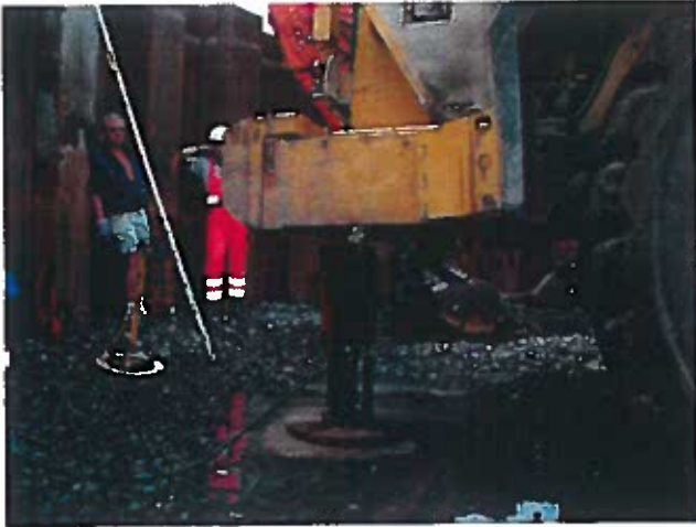
Pladebelastningsforsøg på overfladen
