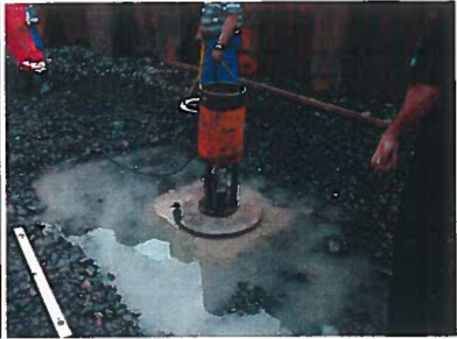
Pladebelastningsforsøg 1m under overflade
