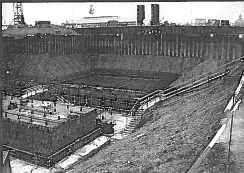
Byggegruben – dobbelte vægge, skrån timer
