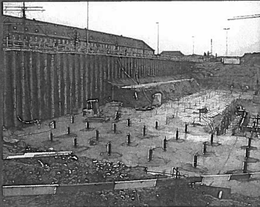
Byggegruben – med jordankre i bund
