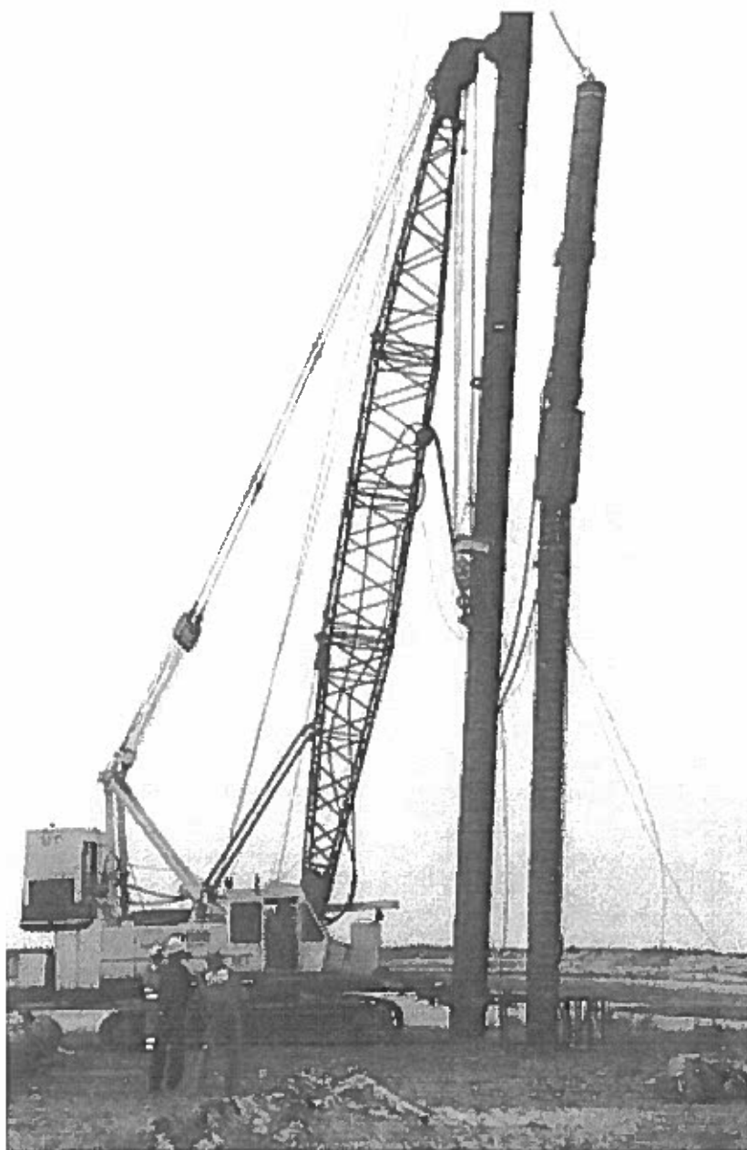
Figur 2.3.1 Ramning af forsøgsmonopæl på land med ekstremt skråt slag ( 2^\circ ) for at undersøge styrke af flange.
