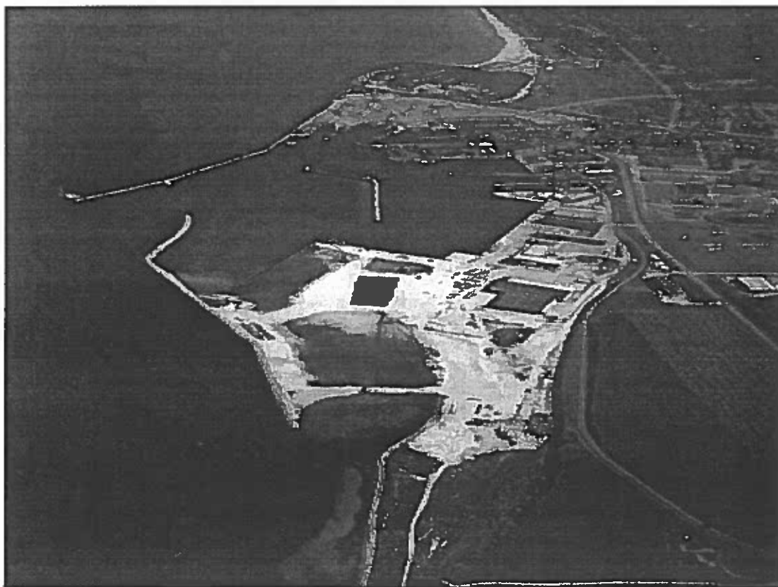
Planethaven, etape 1 under udførelse
