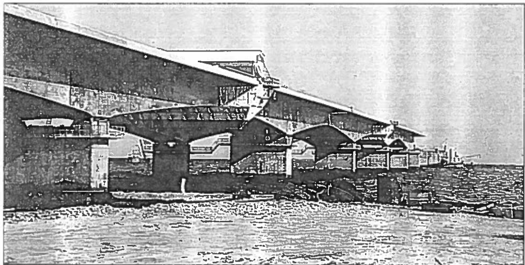
Bild 24. Blick entlang von montierten Straßenträgern mit Schutzzeit für das Betonieren der Fugen in Feldmitte
