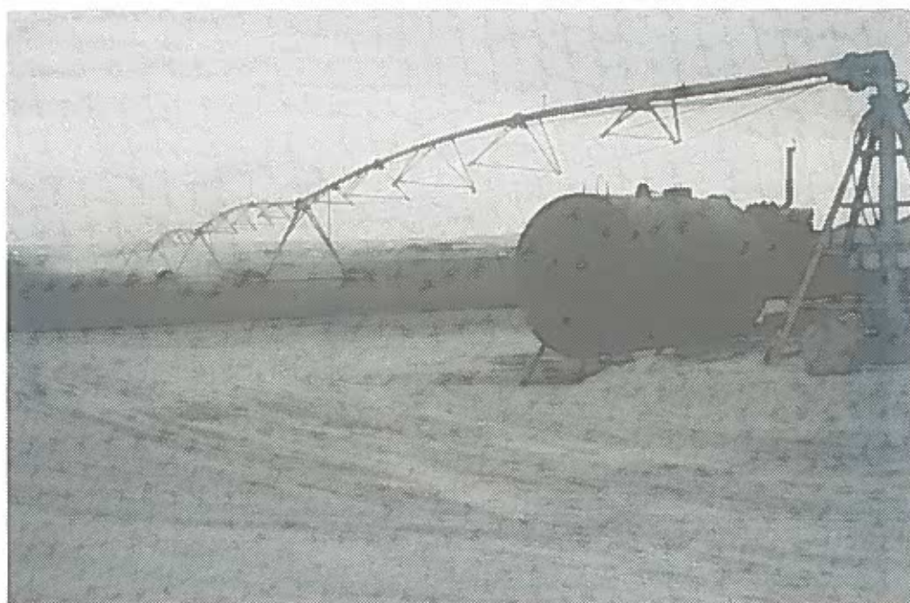
Fig. 22 og 23. Centre pivot anlæg i Saudi Arabien med multisprinkler.
