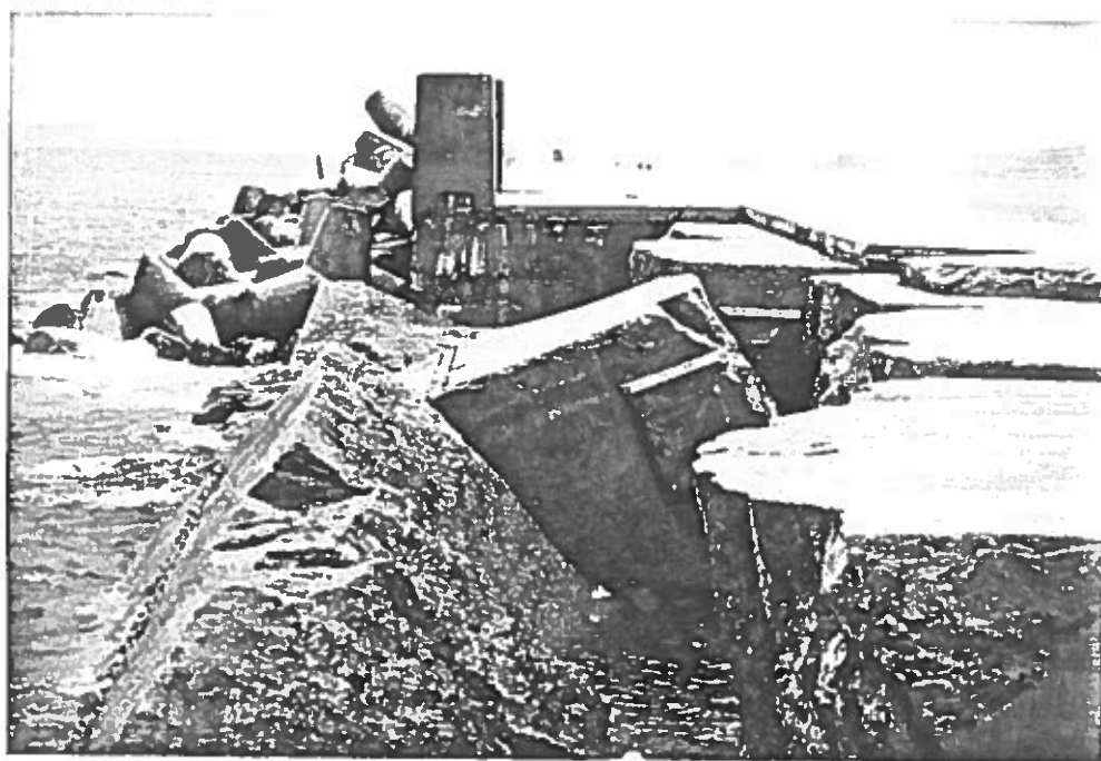
Fig. 4. Port d'Arzew El-Djedid breakwater.
