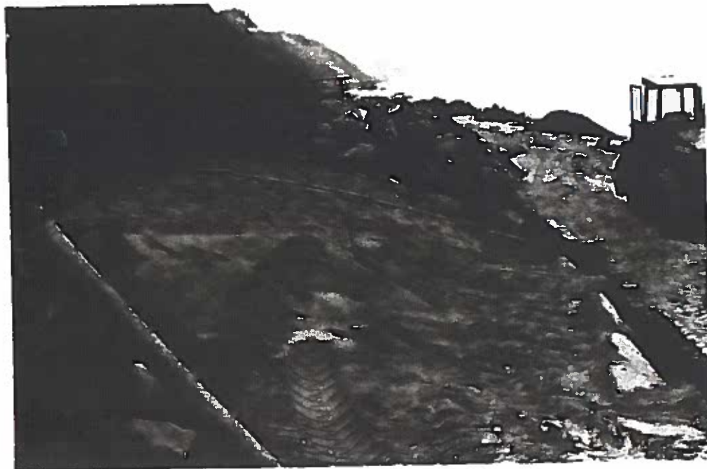
Fig. 5.5 Et kystværn under opbygning. Sandkærnen er bygget foran skrænten og kunststoffilter klart til pålægning, derefter kommer et lag af små sten afsluttet af større sten, der ses oplagret på stranden.
